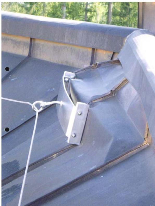
**Danneggiamento della copertura a doppia aggraffatura dovuto al posizionamento errato degli ancoraggi e dalla mancanza del paraneve secondo le specifiche SA.**
